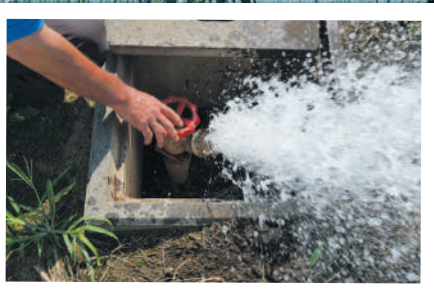
圃場には霞ヶ浦を水源とするパイプラインが整備され、給水等の作業時間の短縮に繋がっている。
